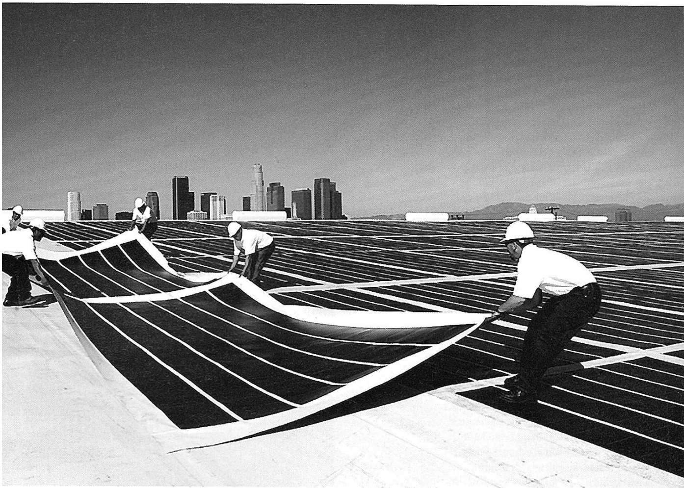
FLEXIBEL: Arbeiter der Solar Integrated legen ein Dach in Los Angeles mit Dünnschicht-Modulen aus amorphem Silizium aus.
