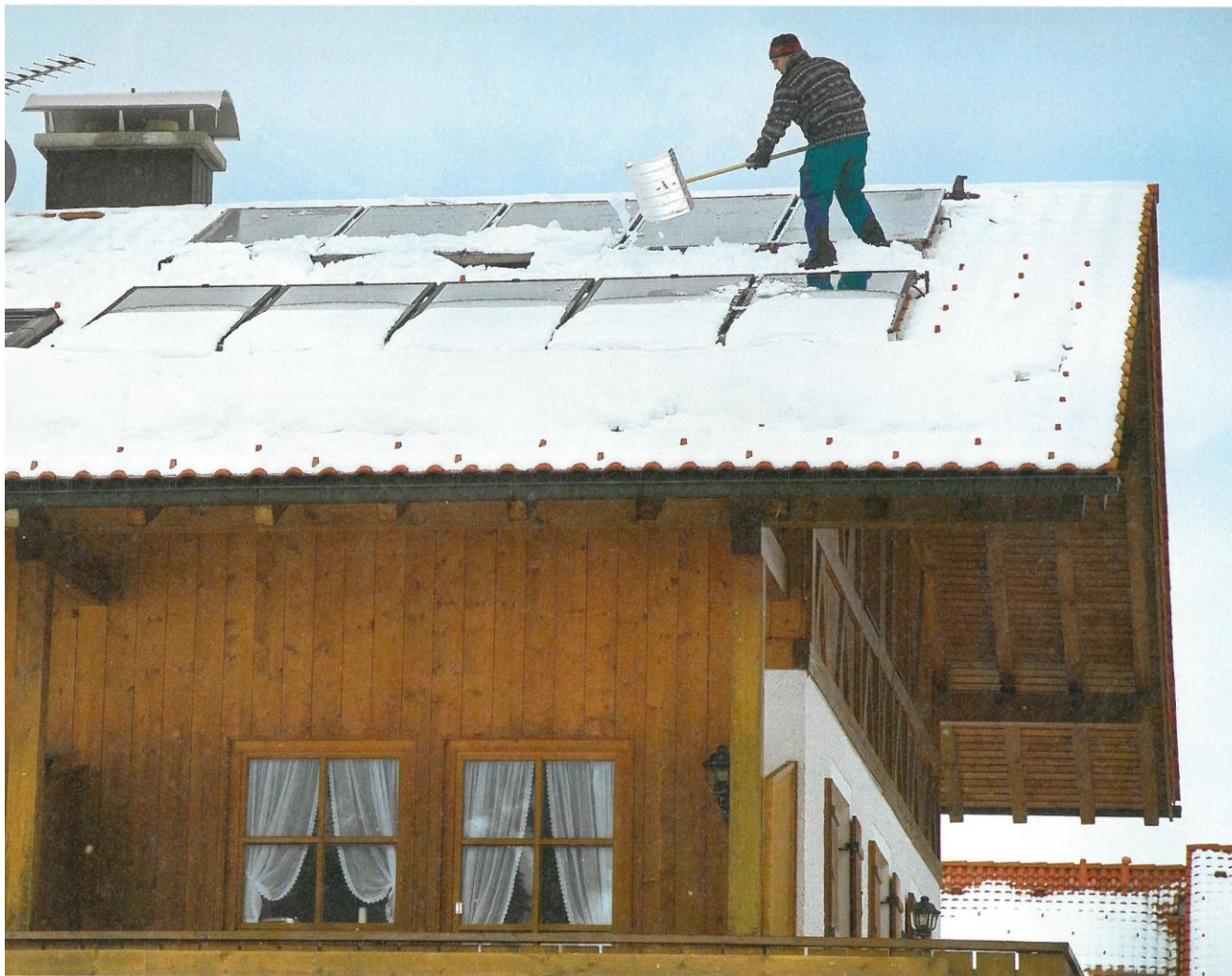
Rauf aufs Dach: Solarthermieanlagen müssen des Winters von Schnee befreit werden – sonst bleibt es kalt im Haus.
