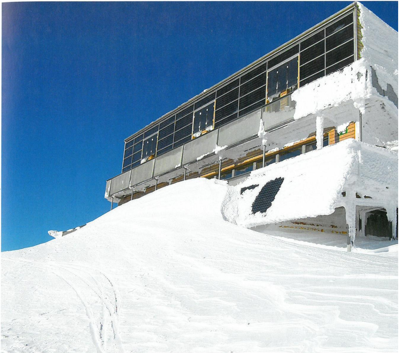
Hochalpines Passivhaus: Eine 46 Quadratmeter große Solarthermieanlage versorgt das Schiestlhaus, Stützpunkt für Bergwanderer in der steiermärkischen Hochschwab-Region, mit regenerativer Wärme.
