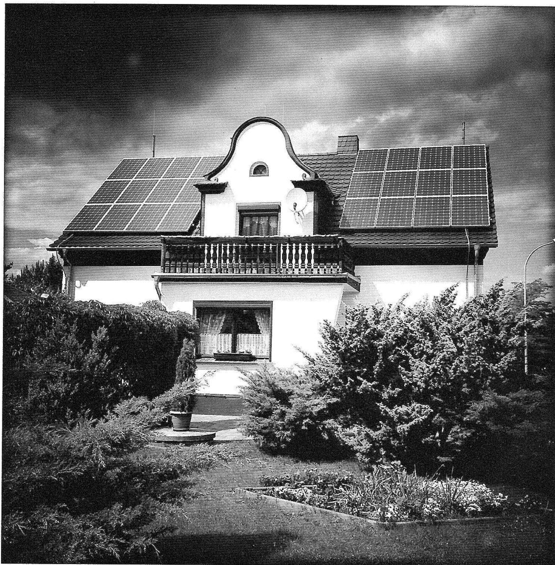
Strom trotz Wolken: Mit einem Batteriespeicher im Keller steht Solarenergie auch dann zur Verfügung, wenn die Solaranlage auf dem Dach vorübergehend keinen Strom liefern kann.
