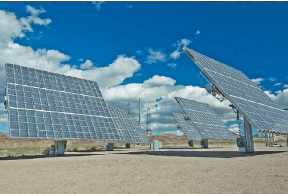
Konzentratorsysteme: Eine Optik bündelt Licht auf winzige Solarzellen.
