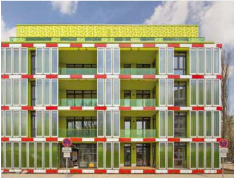
Algenhaus: In der Fassade des «Hauses mit Biointelligenzquotient» in Hamburg erzeugen Algen per Photosynthese Wärme für die Wohnungen.
