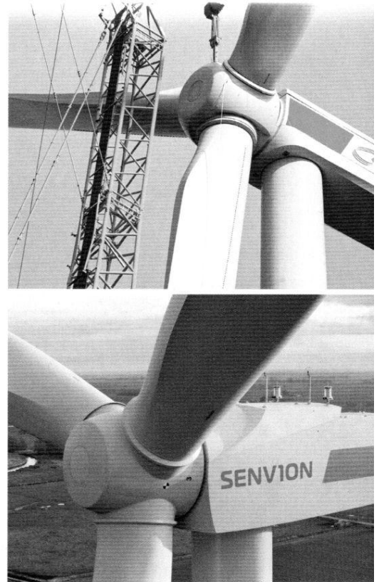
Höhere Türme, größere Rotoren: Viele Hersteller bieten inzwischen speziell für das Binnenland optimierte Windturbinen an. Hier eine Nordex N131/3000 und eine Senvion 3.0M122.
