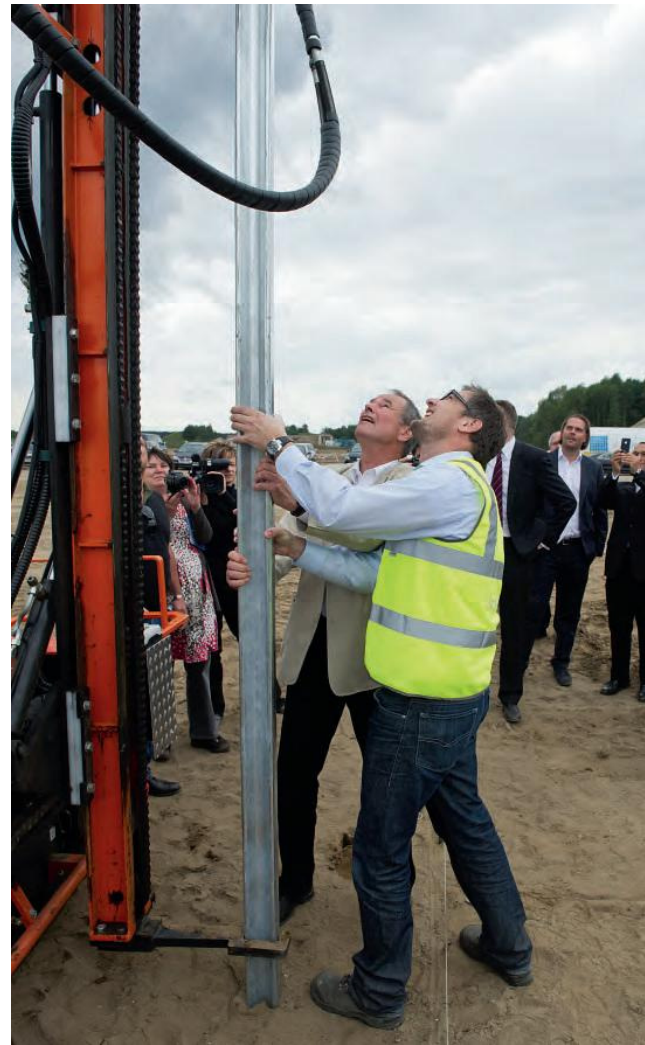
Erster Rammstoß: Anfang September begannen die Bauarbeiten des Solarparks Finow-Tower II.
