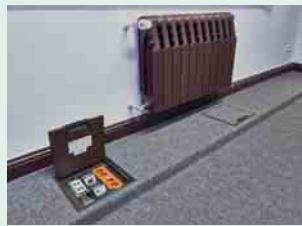
② Praxisbeispiel des Aufbodenkanalsystems
