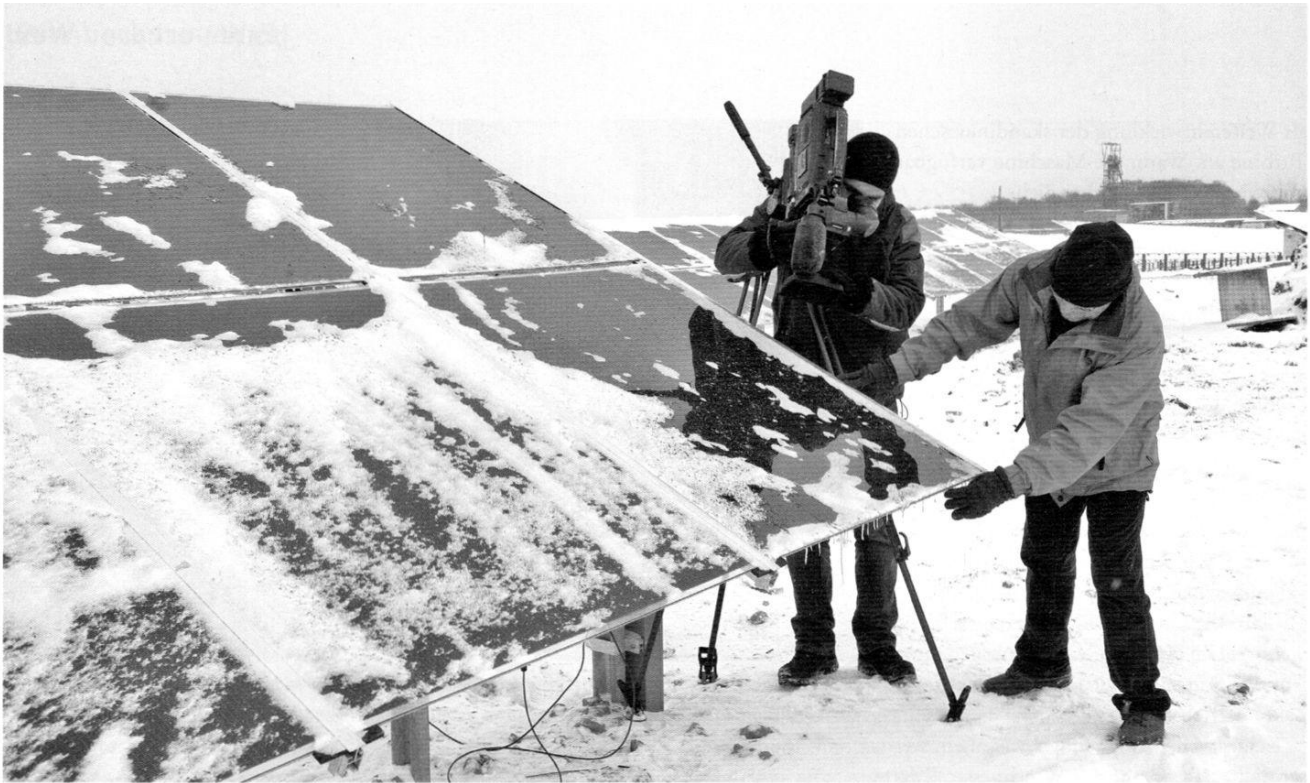
Wetterfest: Trotz des vielen Schnees und eisigen Temperaturen montierten Installateure im Dezember Photovoltaikanlagen von 1455 Megawatt Leistung in Deutschland.
