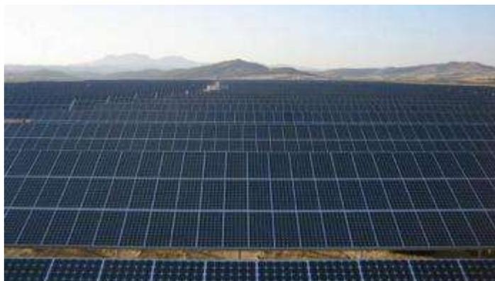
Grenzenlos solar: Die aus kristallinen Modulen von aleo Solar bestehende Freilandanlage "Vidana" mit vier Megawatt Leistung ist nur eines von vielen Solarkraftwerken in Spanien.
