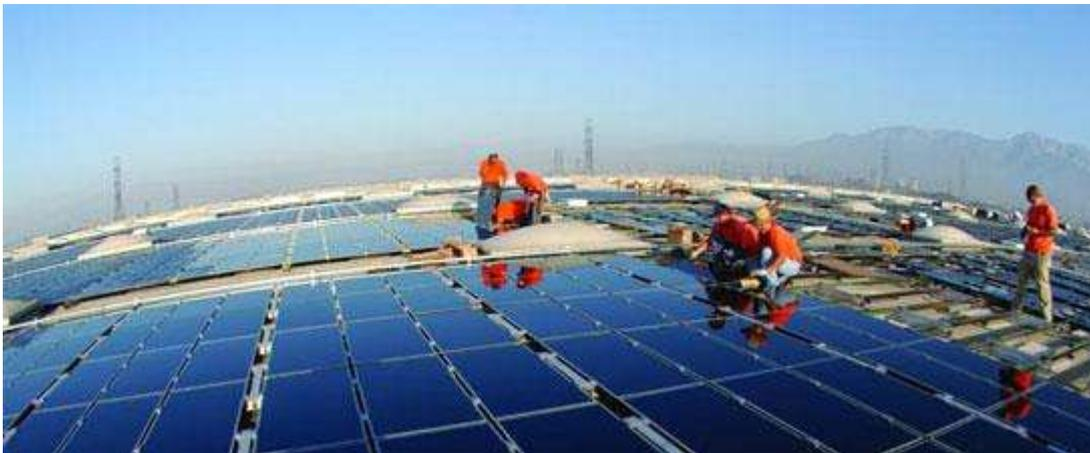
Dünnschicht für US-Dächer: Vor allem in Kalifornien entstehen derzeit überall Photovoltaik-Kraftwerke. Auf diesem Dach in Fontana werden zwei Megawatt First Solar-Module verbaut.
