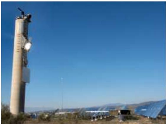
Solartürme sollen der Photovoltaik die Stirn bieten. Sie arbeiten effizienter und weisen höheres Kostensenkungspotenzial auf als die bisher gängigen Parabolrinnen. Bild: DRL
