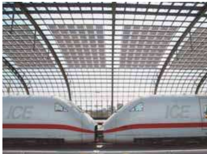
Wegweisend: gebäudeintegrierte PV-Anlage mit Nano-Solarzellen im Berliner Hauptbahnhof. (Quelle: BSW)
