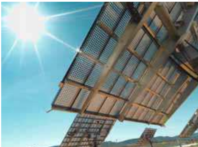
Immer der Sonne nach: Konzentrierende Systeme folgen dem Verlauf der Sonne. (Quelle: Concentrix Solar)
