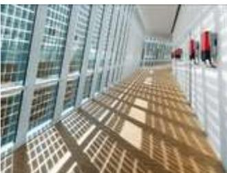
Zukunft der Dünnschicht: Die schlanken Stromgeneratoren sind leicht und flexibel. Damit eignen sie sich gut für die Gebäudeintegration. (Foto: SMA)
