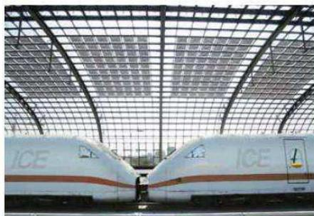
Praxiserprobtes Vorzeigeprojekt: Das Dach des Berliner Hauptbahnhofs verdeutlicht die Vorzüge der BIPV: Die Module erzeugen Strom und lassen zugleich Licht passieren.
