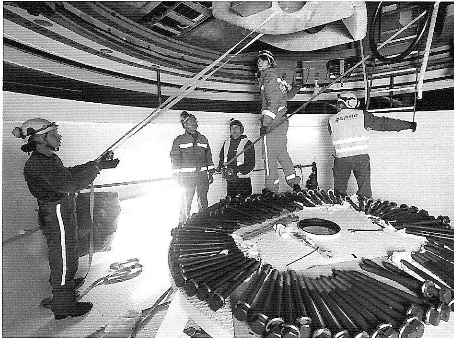
Aufbau mit System: Die Montage einer Gondel wie bei dieser Repower-5M-Anlage könnte sich mit einem einheitlichen Kennzeichnungsverfahren für Windturbinen-Komponenten vereinfachen.
