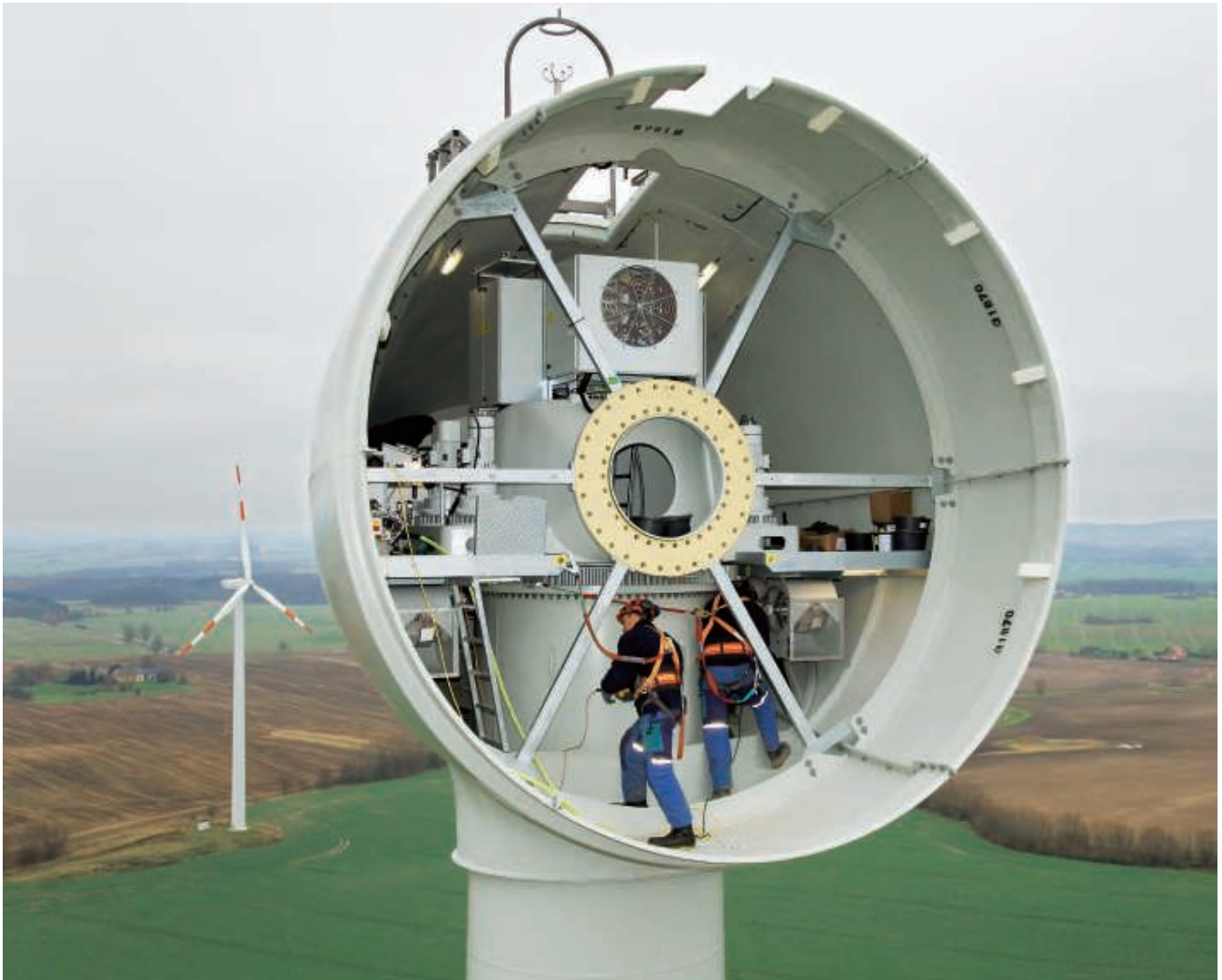
Arbeiten am Maschinenhaus einer Enercon-Windkraftanlage. In rund 100 Metern Höhe gilt es für die Techniker, sich abzusichern.
