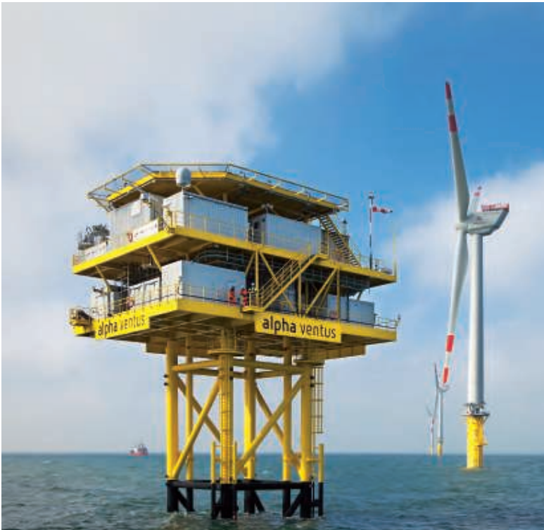
Viel Wind: Hochseebaustelle in der Nordsee
